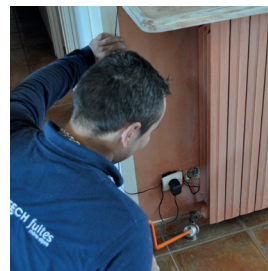
Injection et localisation du gaz traceur.
